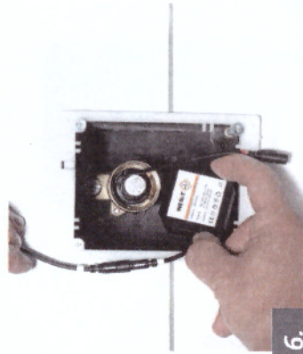
7. Steckverbindung einstecken.
